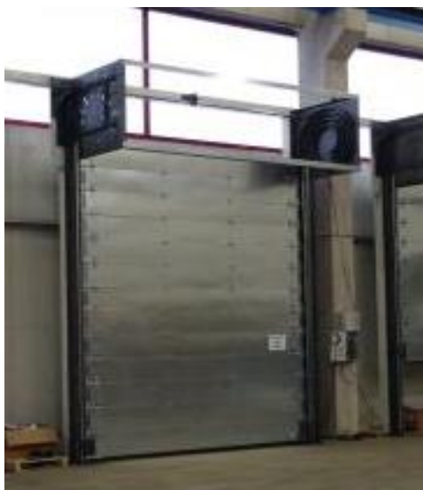
Obr. 1 – Lamelová rychloběžná protipožární vrata – vlevo pohled na instalovaná vrata v dílně, vpravo zkouška protipožární odolnosti v certifikované laboratoři firmy FIRES
